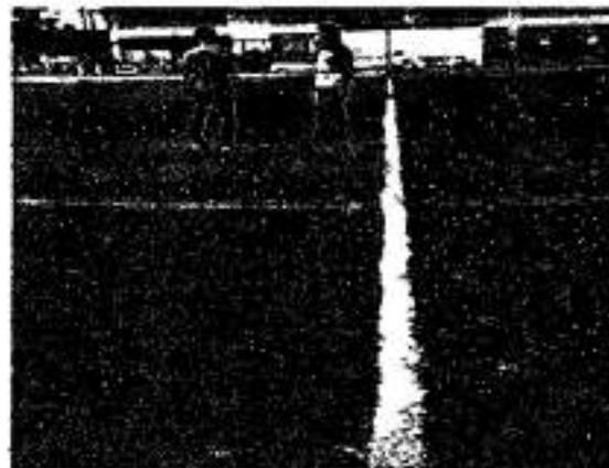
Observación: se evidencia el desprendimiento de las franjas amarilla y blanca de demarcación del área de juego, se recomienda que la franja blanca sea sustituida y la franja amarilla se le aplique un mantenimiento para adhesión.
